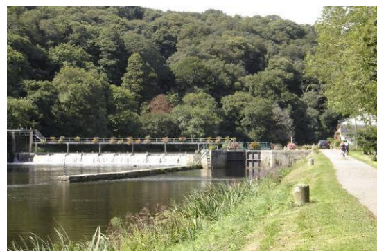
Ouest - écluse de Trébihan
