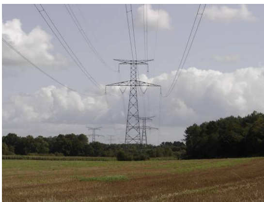
Du sud au nord de la commune...
