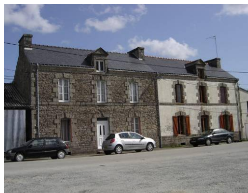
Pont Augan - Maisons entièrement restaurées
