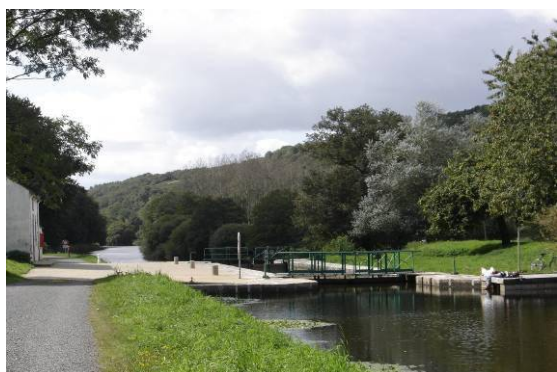
Nord - écluse de Minazen
