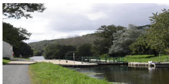
Nord- écluse de Minazen
